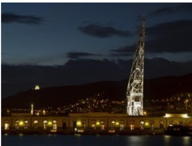
71 metri in altezza e poteva sollevare un carico di 150 tonnellate e fu impiegato per operazioni portuali e anche per la costruzione di grandi navi che venivano costruite nei cantieri dell'Alto Adriatico.
